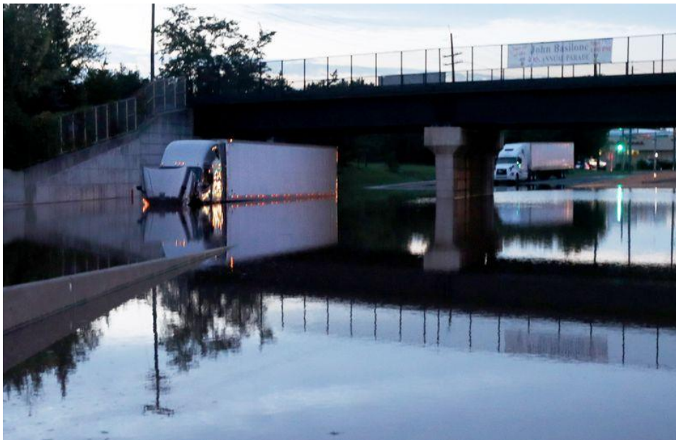
Figura 4: Caminhão preso na água na Rota 206 Norte após a tempestade tropical Ida despejar grande quantidade de chuva em Raritan, NJ, em 2 de setembro de 2021
