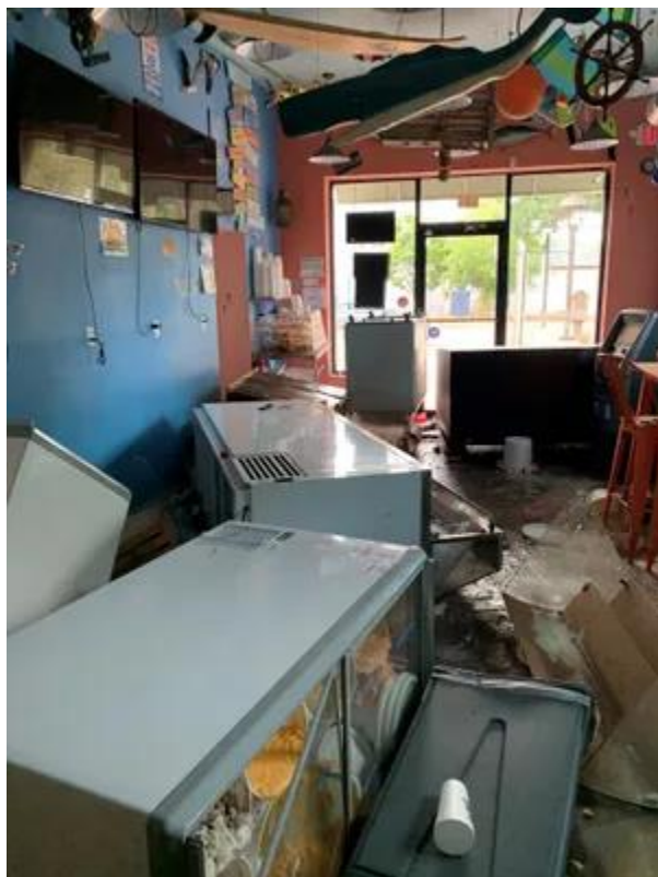
Figura 9: Consequências da inundação na sorveteria Summer Ville, em Somerville, NJ
