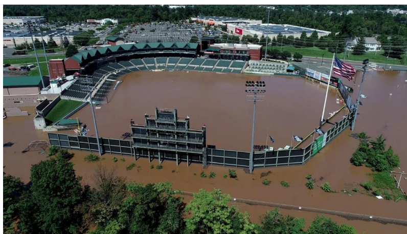
Figura 8: TD Bank Ballpark inundado per águas provenientes do furacão Ida
